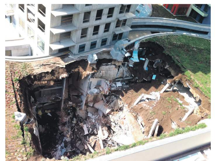
Problémová statika: Apollo 1 (snímka vľavo) prechádza spevňovaním statiky. Zo stavby Centrom v Piešťanoch sa ľudia museli vysťahovať. Na päťpodlažnej budove garáží v projekte 3nity (snímka vpravo) sa prepadol strop.
